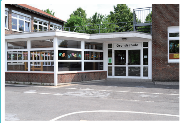
Bild: Grundschule Everswinkel, vor dem Baubeginn des Forums
